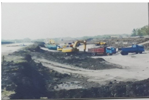
Gambar 3. Pekerjaan Penggalian Tanah Pelurusan Sungai Widas.
