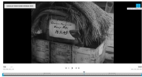
Gambar 6. Simulasi penanggulangan kebakaran dalam perang pada menit 06.12. Sumber: Nippon Eigasha 1943.
